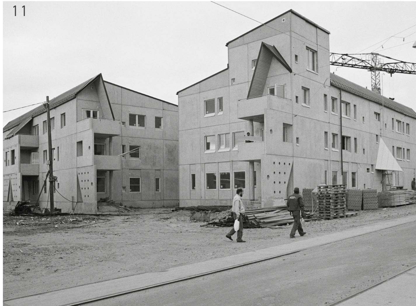
11 Erityisesti asuntorakentaminen nojasi tarkasteluajalla betonielementtijärjestelmään. Rakennustyömaa Pikku-Huopalahdessa Helsingissä. Jan Alanco 1990. HKM.
